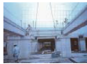
現地での取り付け状況
