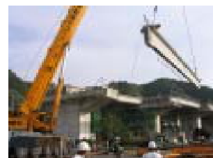
現地での橋桁架設状況
