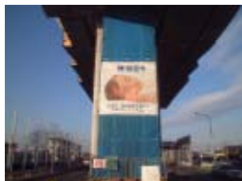
大治作業所工事案内垂れ幕
