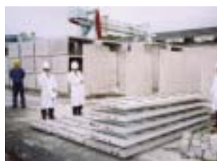
工場での製品検査状況
