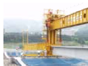
現地での橋桁架設状況
