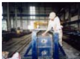
工場での製作状況
