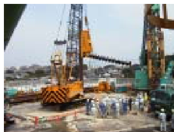
鳴海共同溝作業所見学会
