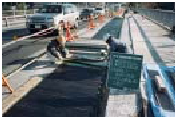
床版上面の炭素繊維シートによる補強
