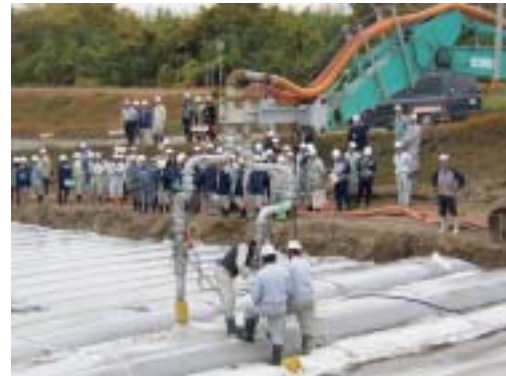
河跡湖から浚渫した底泥を充填し、袋体を盛土材として
