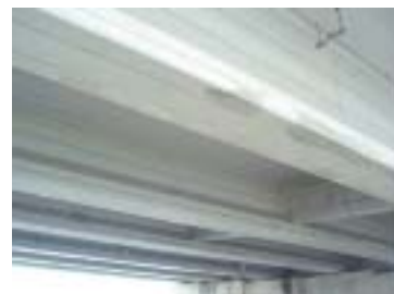
相模湾に面した道路橋における電気防蝕工事の仕上がり状況
