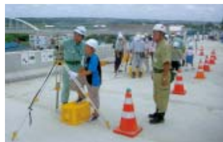
圏央道さがみ縦貫道路渡河橋上部工事 【神奈川県相模原市:PC6径間連続箱桁橋】 橋面で測量作業のデモンストレーションを体験する子どもたち。 現場職員が優しくサポート。07年8月2日の親子見学会にて
