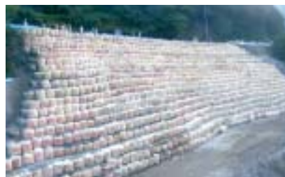
9日間にわたる復旧工事完了 道路の開通へ
