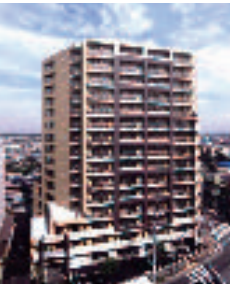
(仮称)原町田プロジェクト新築工事
