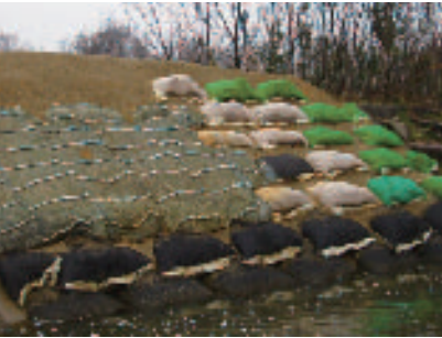
【施工後】 法面植生直後
