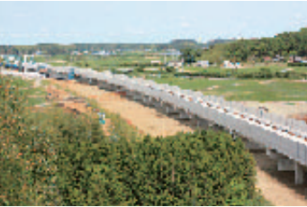
成田高速線松虫川橋梁外18カ所(PC桁)工事
