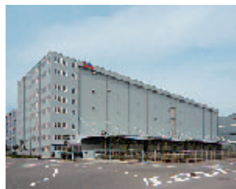
ダイソーコーポレーション南本牧倉庫
