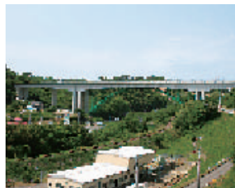
常磐自動車道西田橋
