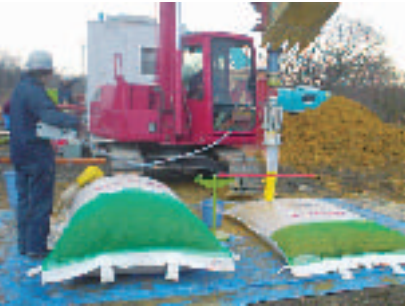
【施行中】 SPADシステムによる充填
