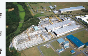
ピー・エス・コンクリート(株) ■茨城工場
