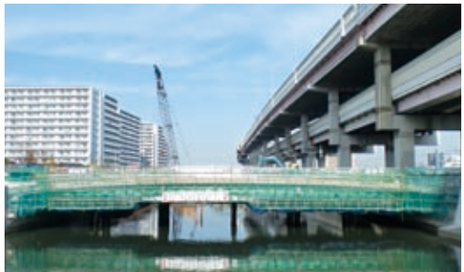
綾瀬川水戸橋架替工事に伴うPCけた製作・架設工事
