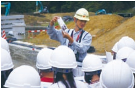
贈呈記念品も用意された現場見学会では、工事について小学生向けのわかりやすい解説が好評でした。
