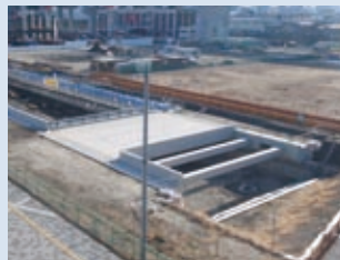
都計笹島線 H型PC杭によるアンダーパス側壁
