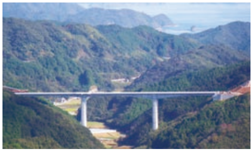
平成20～22年度大坂谷川橋上部工事
