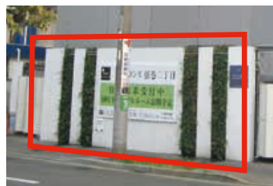
周囲の住環境にも配慮し、仮囲いの一部に緑化壁を設置しています。
