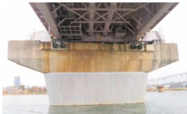
長柄橋耐震補強工事(水中施工)
