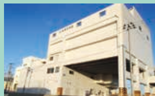
石巻市漁業協同組合 製氷・貯氷施設 PCaPC造一部RC造 地上5階建て 延べ床 3,359m 2
