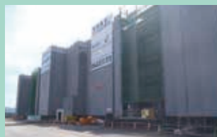
石巻復興住宅（施工中） WPC造 住宅棟 5階建て 集会所 平屋建て 延べ床 4,812m 2
