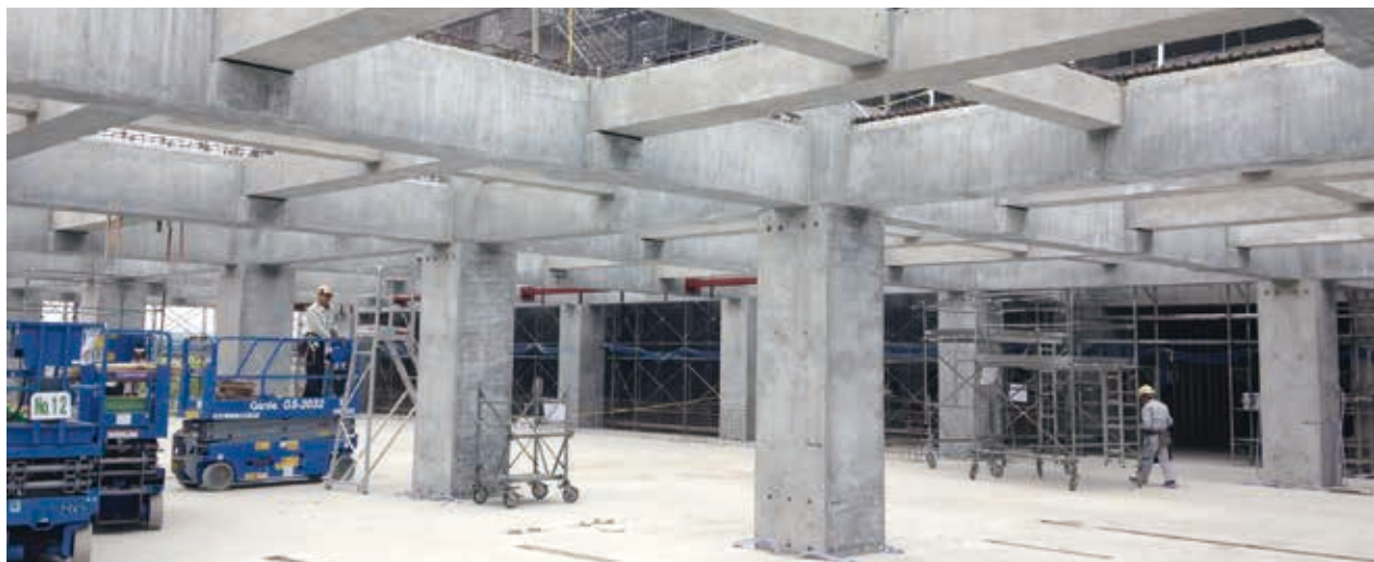
柱、梁部材架設状況(体育館棟)
