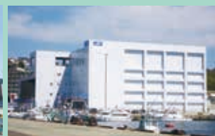
福島県冷凍冷蔵倉庫 PCaPC造 地上5階建て 延べ床 10,193m 2
