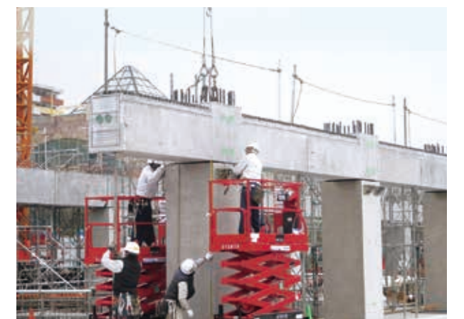
柱部材へのレンコン梁部材架設作業
