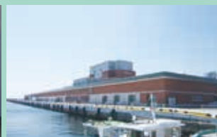
小名浜漁協荷捌所 RC・S・SRC・PC造 荷捌部：平屋建て 管理棟：3階建て 延べ床 6,965m 2
