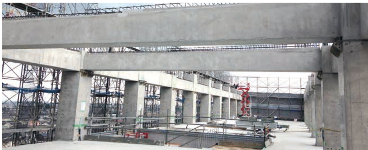
13mの梁部材架設状況(校舎棟)
