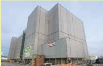
転落防止および塗料飛散防止のため メッシュシートにて養生を行う
