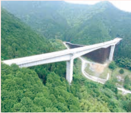
中部横断自動車道 長瀬川橋工事
