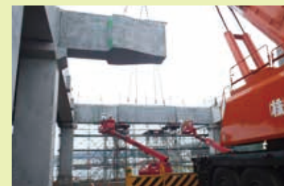
接合部大梁架設
