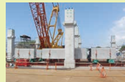
大梁連結工 (軌条設備全景)
