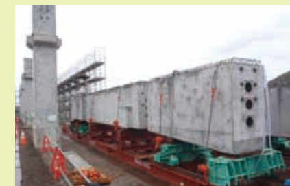
大梁連結工 (軌条設備)
