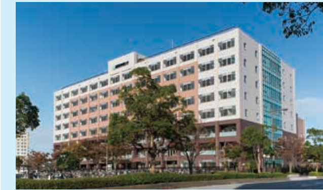
国際医療福祉大学 成田看護学部・成田保健医療学部 新築工事
