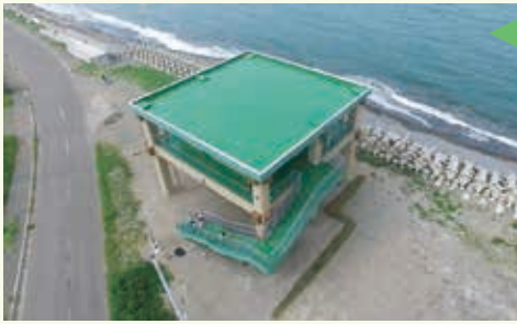
場所：北海道野付郡別海町野付 竣工：2016年4月 規模：2階建て 建築面積101.8㎡ 避難階高 6.6m 避難スペース 85.25㎡ 避難人数 164人 構造：プレキャストプレストレスト (PCaPC) 造
