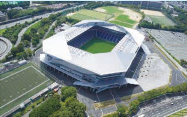
大阪市立吹田サッカースタジアム PC躯体工事
