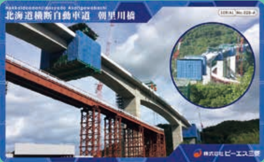
北海道横断自動車道朝里川橋(PC上部工)工事 (北海道)
