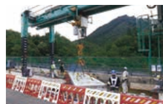
③プレキャストPC床版の架設
