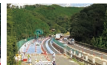
④施工状況
