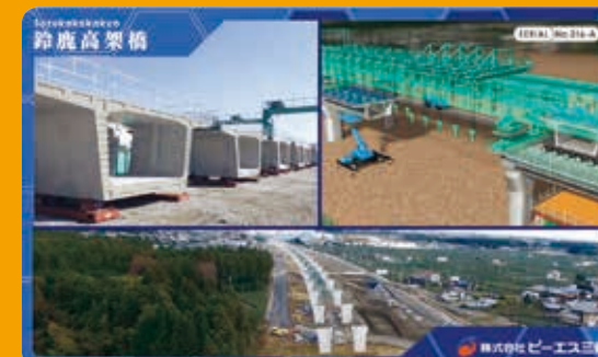
新名神高速道路鈴鹿高架橋他1橋（PC上部工）工事（三重県）
