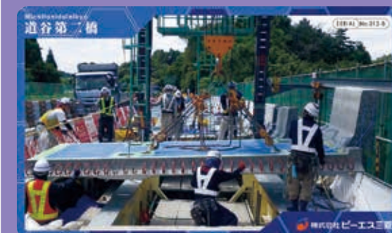
中国自動車道(特定更新等)道谷第二橋(上り線)床版取替工事(山口県)
