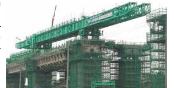
大型架設機材
