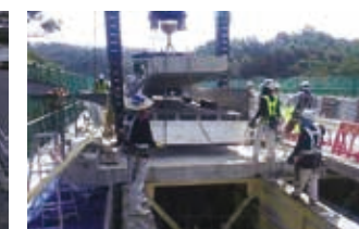
②既設床版の撤去
