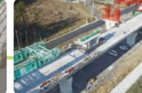
**11 特殊車軸台車にて大型架設機まで運搬**
