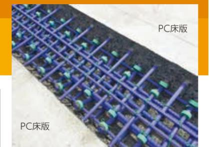
プレキャストPC床版同士の隙間を後打ちコンクリートにより埋める「間詰め部」では、従来、「ループ継手」が鉄筋継手として用いられてきました。この継手を、独自開発の「ネジ節鉄筋」と「円形ナット」を用いた構造とすること
