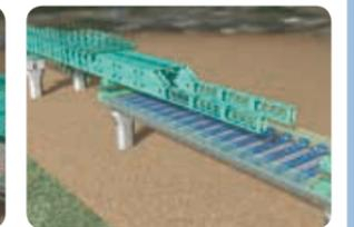
先方の橋台に支持架台を設置して、大型架設機を移動し、次の径間の架設を実施
