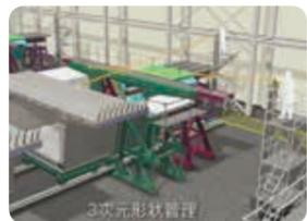
レーザー使用の3次元形状管理にて架設後の形状を逐次確認
