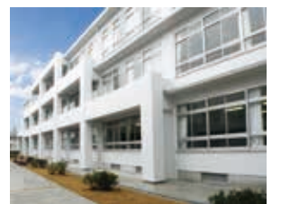
PCaPC外付けフレーム耐震補強工法
