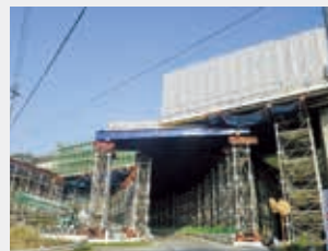
県道上の支保工施工
