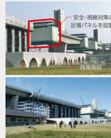
商業施設隣接部の 固定支保工
