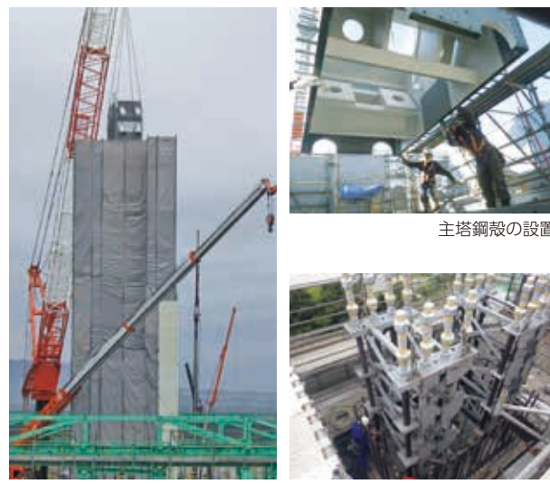
550tクレーンによる鋼殻の架設
