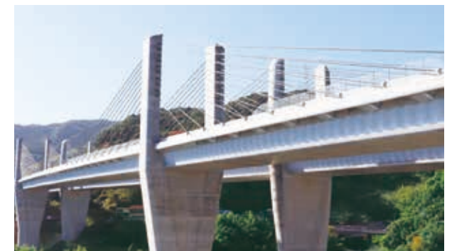
2面吊り構造(日見夢大橋・長崎県) 主塔から橋桁の両側面に渡したケーブルで支持
