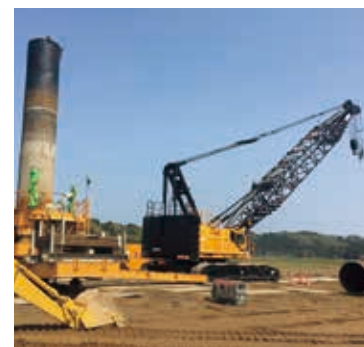
つばさ杭施工状況
