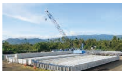
サモアPC橋梁工事(施工中)
