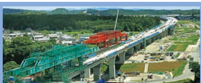
鈴鹿高架橋工事(2019年1月竣工) 新名神高速道路・鈴鹿PA付近(CSR REPORT 2018特集)
