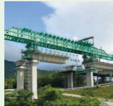
スパンバースパン架設機(鈴鹿高架橋)
