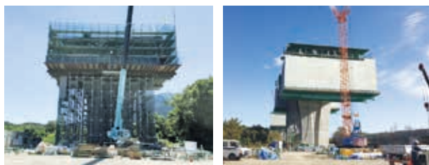
柱頭部支保工 大型ワーゲン(移動作業車)を使用
