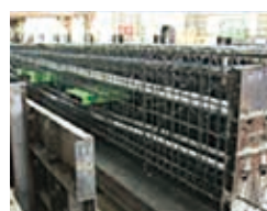
鋼製の型枠をセット
