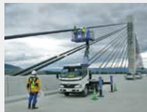
防火カバーの取り付け
