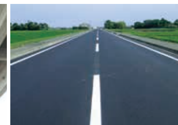
県単舗装道路修繕・維持工事(千葉県)
