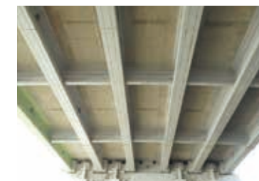
電気防食補修工事(神奈川県)
