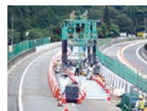
高速道路橋の床版取り替え工事
