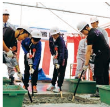
鈴鹿高架橋(三重県)
