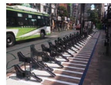
2018年度に完成したJR赤羽駅東口自転車駐輪場
