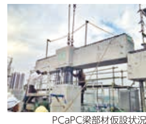
PCaPC梁部材仮設状況
