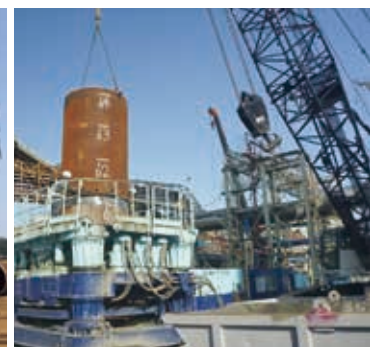
大深度 杭施工状況
