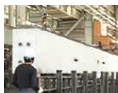
コンクリート養生後に脱型
