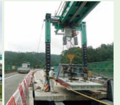
床版取替工事の機材(道谷第二橋)
