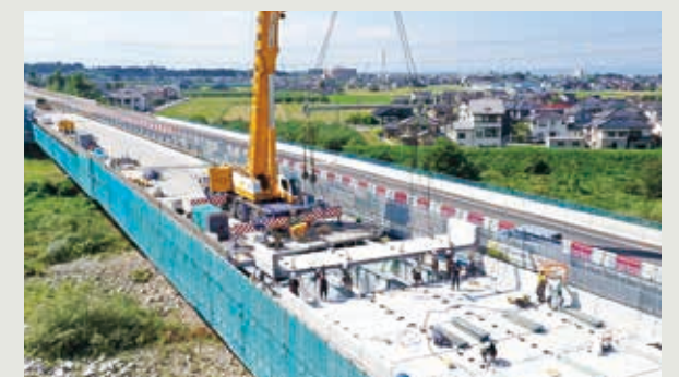
プレキャストPC床版架設状況
