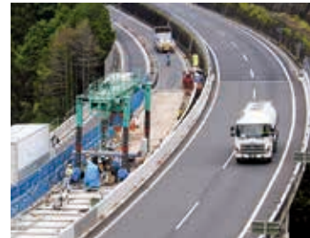
床版取替工事の機材(大谷橋)
