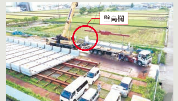
壁高欄付きのプレキャストPC床版の出荷状況
