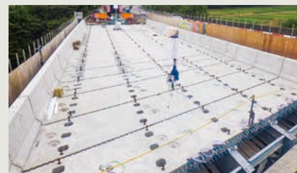
橋桁の上に据付けられたプレキャストPC床版
