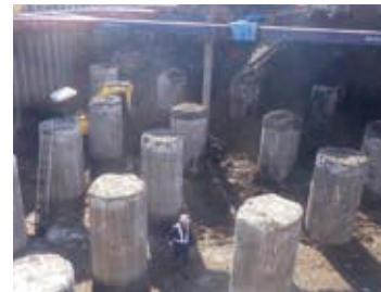
杭打設完了後の杭頭部確認
