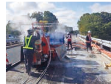
中国自動車道大規模更新工事(広島県)
