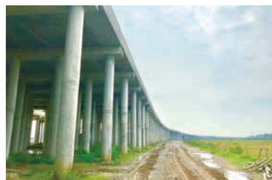
KOBЕ社のプレキャストPC部材を採用した高速道路
