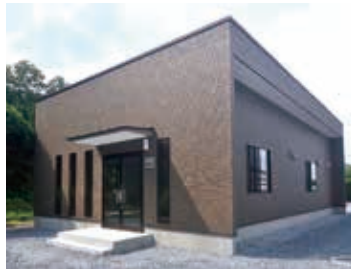
北房機材庫事務所外観
