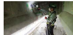
リパッシュ工法:真空ポンプでシース内の通気を確認
