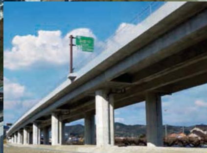
2020年度竣工 阪和自動車道みなべ高架橋他2橋(PC上部工)工事(和歌山県)
