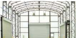
PSM社技術研究所テント作業場棟新築工事
