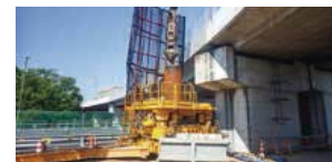
自動車道耐震補強工事(高速道路関連)
