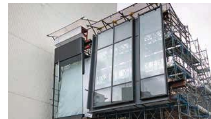
作業現場のスペースが限られていたため、休憩所近くに足場を組んで設置
