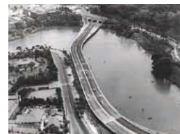
1963年 「首都高速道路4号線千鳥ヶ淵高架橋」: クロソイド曲線の緩やかなカーブを描くPC橋梁
