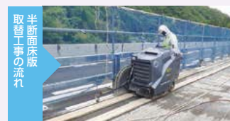
目地部分の切断
