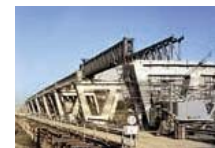
1978年 「北陸自動車道・金沢高架橋」: 移動支保工方式による国内最大級の橋長(約2.7km)を実現
