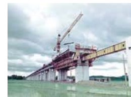
1975年 「東北新幹線・第一北上川橋梁」: 国内で初めてPC橋梁工事に可動(移動)支保工を導入
