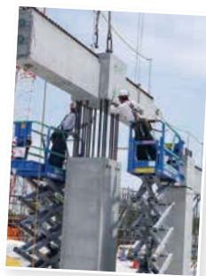
ピー・エス・コンクリート社で製作した部材をピーエス三菱の建築施工現場にて架設・接合
