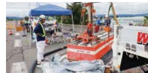
NSRV工法:ウォータージェットで断面修復
