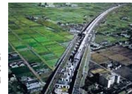
1978年 「北陸自動車道・金沢高架橋」: 移動支保工方式による国内最大級の橋長(約2.7km)を実現
