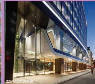
エントランス外観
