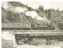
1954年 「信楽高原鉄道第一大戸川橋梁」: 橋梁長大化の期待を上げた本格的 PC鉄道橋。国の登録有形文化 財(建造物)に登録(2008)
