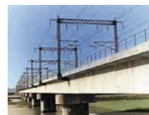
1970年 「山陽新幹線加古川橋梁工事(山崎賞受賞)」: 国内初のプレキャストセグメント工法を導入
