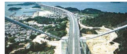
1988年 「本州四国連絡橋小島坂出ルート・樫石島高架橋」: 当時の最新橋梁建設技術の集大成ともいえる道路鉄道併用2階建PC高架橋
