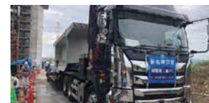
プレキャスト製品を運び大型車両
