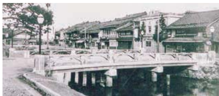
1952年 「長生橋」: 供用50年後も“健全性”が確認された国内初のPC橋
