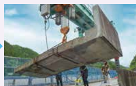
既設RC床版の撤去
