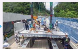
PC床版の設置
