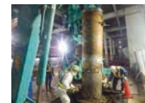
空頭制限下での杭施工(鉄道関連)
