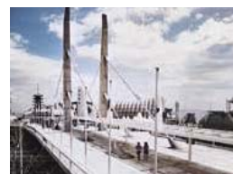
1970年 「万国博覧会西ゲート入口歩道橋」: 国内初のPC斜張橋
