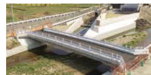
飛鳥川橋梁上部工事
