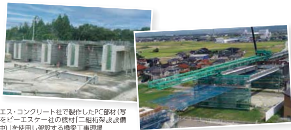
ピー・エス・コンクリート社で製作した部材をピーエス三菱の建築施工現場にて架設・接合
