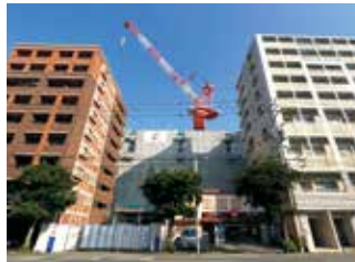
建物内の タワークレーン
