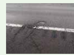
ポットホールと路面のひび割れ
