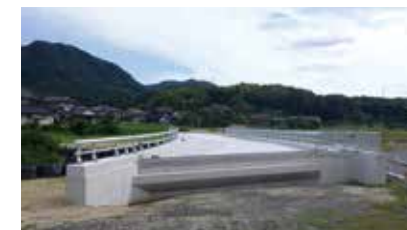
橋梁新設工事(新本川橋(仮称)上部工)
