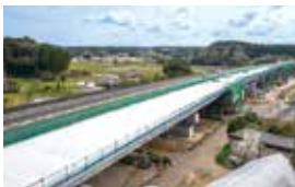
古和高架橋工事(千葉県山武市)
