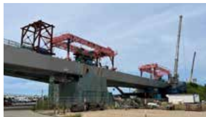
新手指川橋床版架設機
