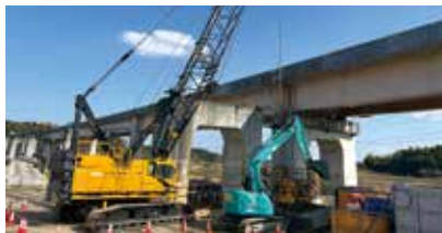
圏央道増杭工事
