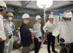
大学生向け現場見学会 東海環状自動車道北勢第三高架橋工事 (三重県)
