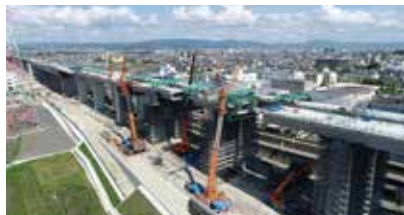
城陽第二高架橋東工事
