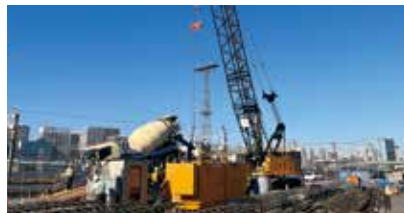
羽田アクセス線八潮工区
