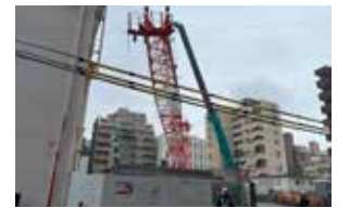
実際のクレーン組み立て作業
