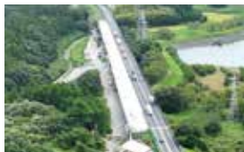
吉原高架橋工事(茨城県土浦市)
