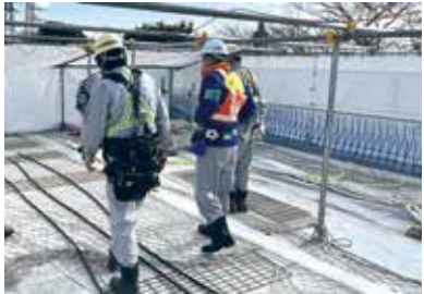
社長・年頭パトロール (図央道吉原高架橋工事)
