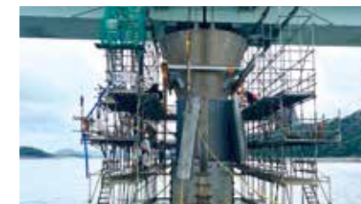
コンファインド工法による川内河口大橋耐震補強(P3)工事
