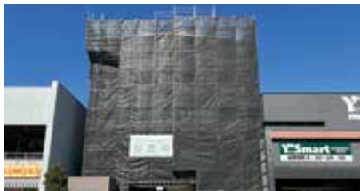
某ビル大規模修繕工事
