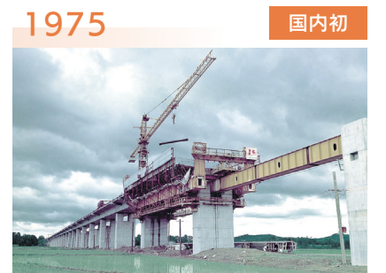
1975 国内初 第一北上川橋（岩手県） PC橋工事に可動（移動）支保工を採用
