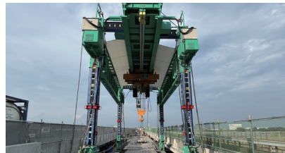
プレキャストPC床版用移動敷設クレーン
