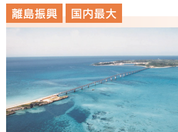
離島振興 国内最大 池間大橋（沖縄県1986-1992） 国内最大橋長（1,425m）のPC橋。経済・医療福祉・教育文化面の「離島苦（島ちゃび）」を解消
