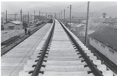
PCマクラギ 1964年の東海道新幹線工事では160万本余りのPCマクラギを使用。当社は年間10万本を製作
