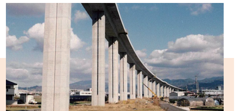
四国縦貫自動車道重信川高架橋（愛媛県1996） PC上部工工事が「試金石」に ショートラインマッチ方式によるプレキャストセグメント橋の本格デビュー。スパンバイスパン工法の初採用で架設をスピードアップ。日本道路公団はこの 工事の成功を踏まえ、第二東名・名神工事の施工条件（左記）を決定
