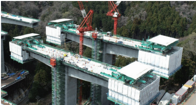
片持架設移動作業車(尺里川橋)
