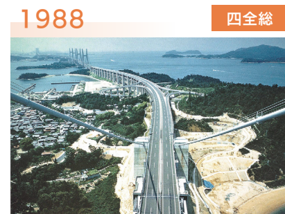
1988 四全総 本州四国連絡橋児島坂出ルート・橋石島高架橋（香川県） 当社をスポンサーとする国内初のPC專業企業JVでの施工。道路上下線と鉄道を1台で施工でき、道路幅の変化に応じて横移動も可能な大型移動支保工（サポートタイプ）を開発
