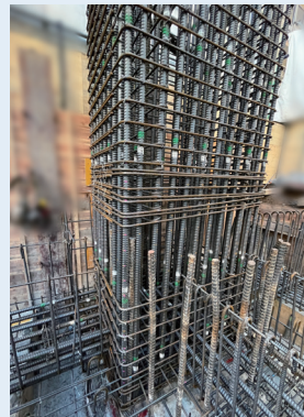
基礎パネルゾーン配筋納まり
