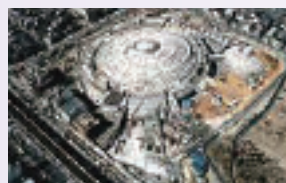
大阪市中央体育館メインアリーナPC工事 (大阪府1996)【PC工事】
