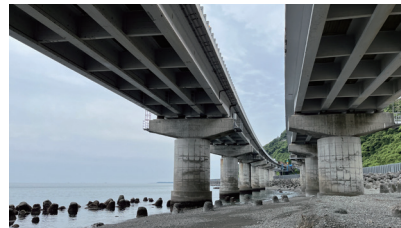
薩埵高架橋/全景
