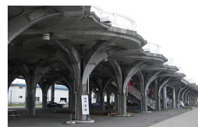
青苗漁港 (北海道2000)【PC工事】
