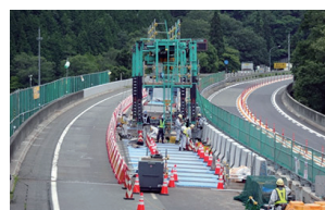
中国自動車道道谷第二橋(山口県2017)
