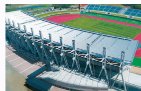
三重交通Gスポーツの杜 伊勢陸上競技場 (三重県2017)【PC工事】
