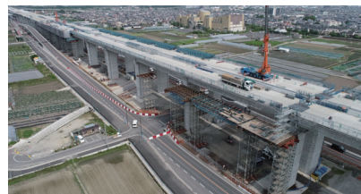
城陽第二高架橋東工事
