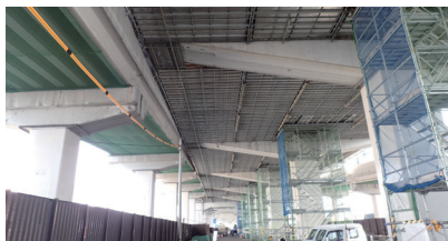
阪神高速池田線大規模修繕工事
