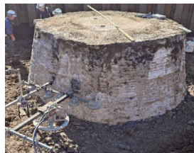
newACE工法掘り出し調査試験
