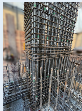
基礎パネルゾーン配筋納まり
