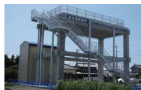
掛川市津波避難施設 (静岡県2012)【PC工事】
