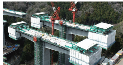
片持架設移動作業車(尺里川橋)
