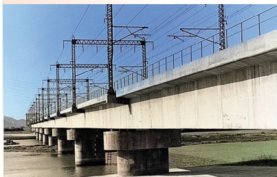
山陽新幹線加古川橋梁(兵庫県) 鉄道橋に国内初のプレキャストカンチレバー工法を採用
