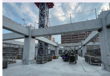
福岡中央病院建替工事 (福岡県2025)
