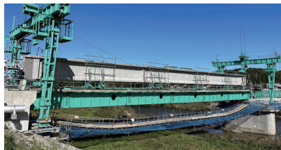
架設機(梯川橋梁)
