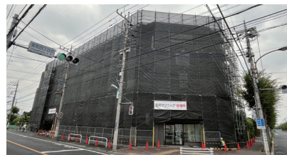
ビル大規模修繕工事
