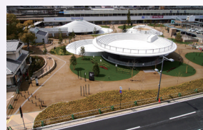
天理駅前広場「コフフン」 (奈良県2016)【PC工事】
