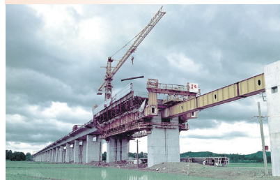
第一北上川橋(岩手県) PC橋工事に可動(移動)支保工を採用
