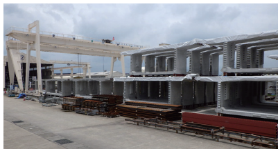
城陽第二高架橋東
