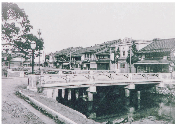
国内初のPC橋 長生橋 （石川県1952.2）
