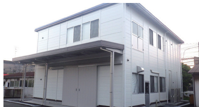
PSC水島工場新試験室増築工事
