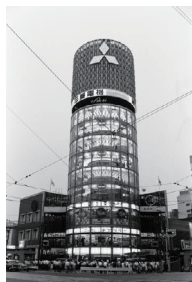
銀座三愛ビル(東京都1962)【PC工事】 上階をPCスラブで構築した銀座のランドマーク
