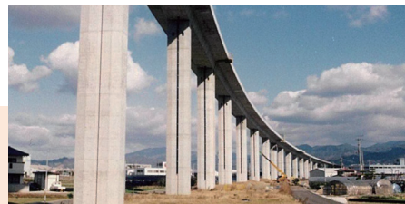
四国縦貫自動車道重信川高架橋(愛媛県1996)
