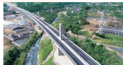
新名神高速道路菰野第二高架橋工事(三重県2019)
