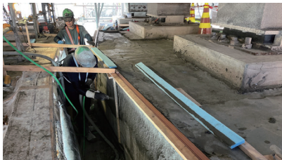
薩埵高架橋/施工状況
