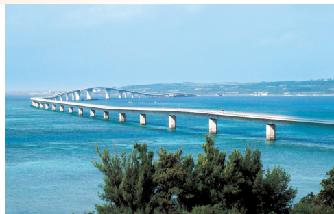
伊良部大橋(沖縄県2006-2015)
