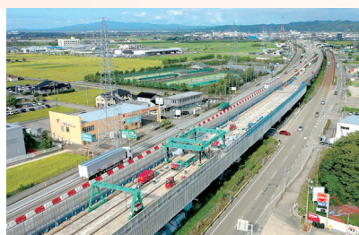
北陸自動車道金沢高架橋(石川県2029)
