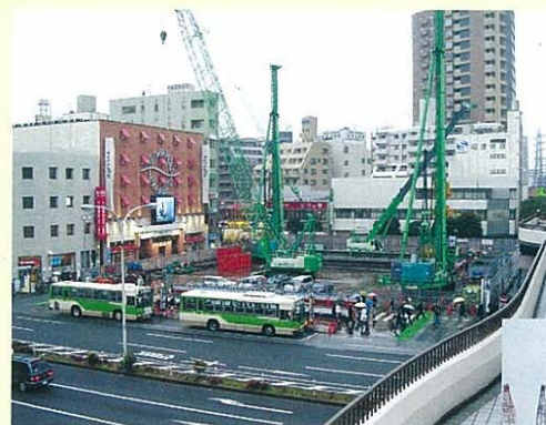
〈西葛西駅前地下駐輪場工事〉
