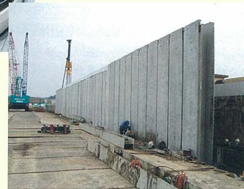
〈宮崎市富吉浄水場工事〉
