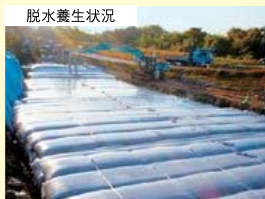
脱水養生状況
