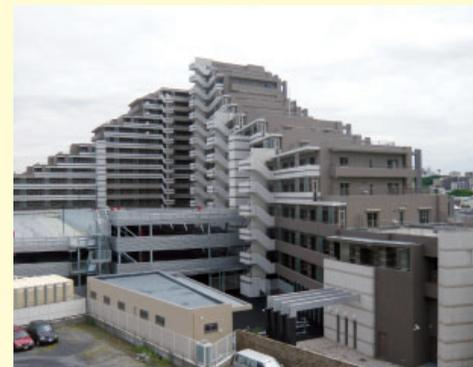
豊かな緑と陽光に包まれた「ザ・クレストリヴァシス」は15階建て、307戸の分譲マンションです。設計時は在来工法で検討されていましたが、4棟がEXP. J（エキスパンションジョイント）でつながれているという建物形状の複雑さを考慮し、躯体の部分的なPCa化で実現させました。バルコニー・外廊下・庇・外部階段・外部マリオン・棟間妻壁等の躯体にPCa化を採用することで施工作業の省力化、安定した部材品質の確保と竣工後の不具合低減を図ることができました。難易度の高い物件でしたが、PCa化のメリットを最大限に活かした高品質・高耐久の建物です。
