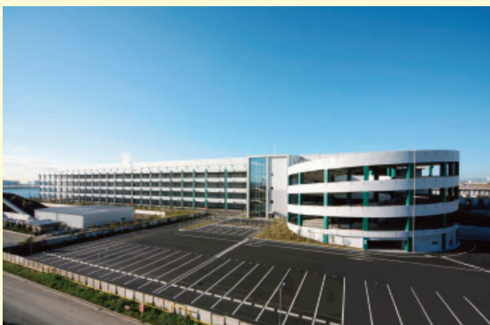
※PC躯体工事
