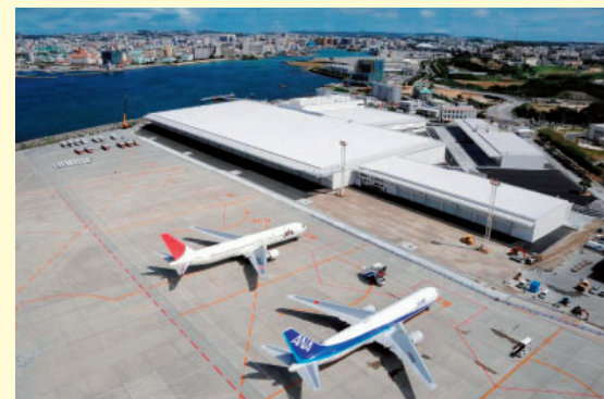
※PC躯体工事
