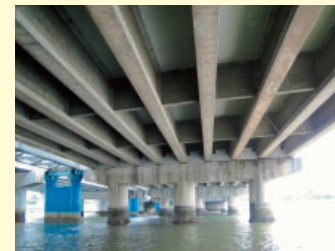
【施工前 下面より】
