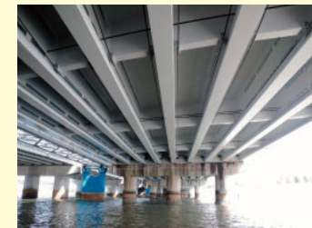
【施工後 下面より】
