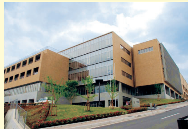
※PC躯体工事
