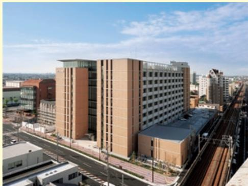
刈谷市役所新庁舎は、旧庁舎の老朽化、耐震性、ユニバーサルデザインの問題を解決するために建設されました。建物は庁舎棟と駐車場棟に分かれ、庁舎棟は鉄骨鉄筋コンクリート造10階建て免震構造であり、内部大空間を確保するため、大型PC合成床版（ST版）が採用されました。
