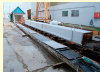
プレテンション方式PC桁の製作
