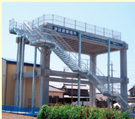
今沢津波避難施設
