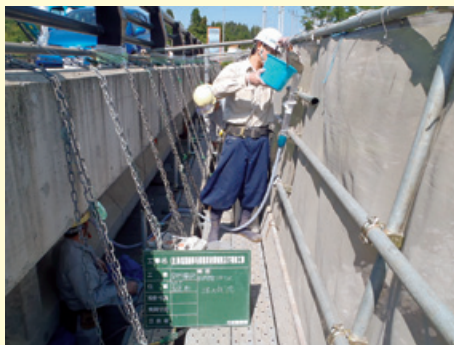
施工状況（亜硝酸リチウム水溶液注入状況）
