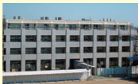
ピース三菱PCaPC外付けフレーム耐震補強の適用事例
