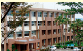
ピース三菱PCaPC外付けフレーム耐震補強の適用事例
