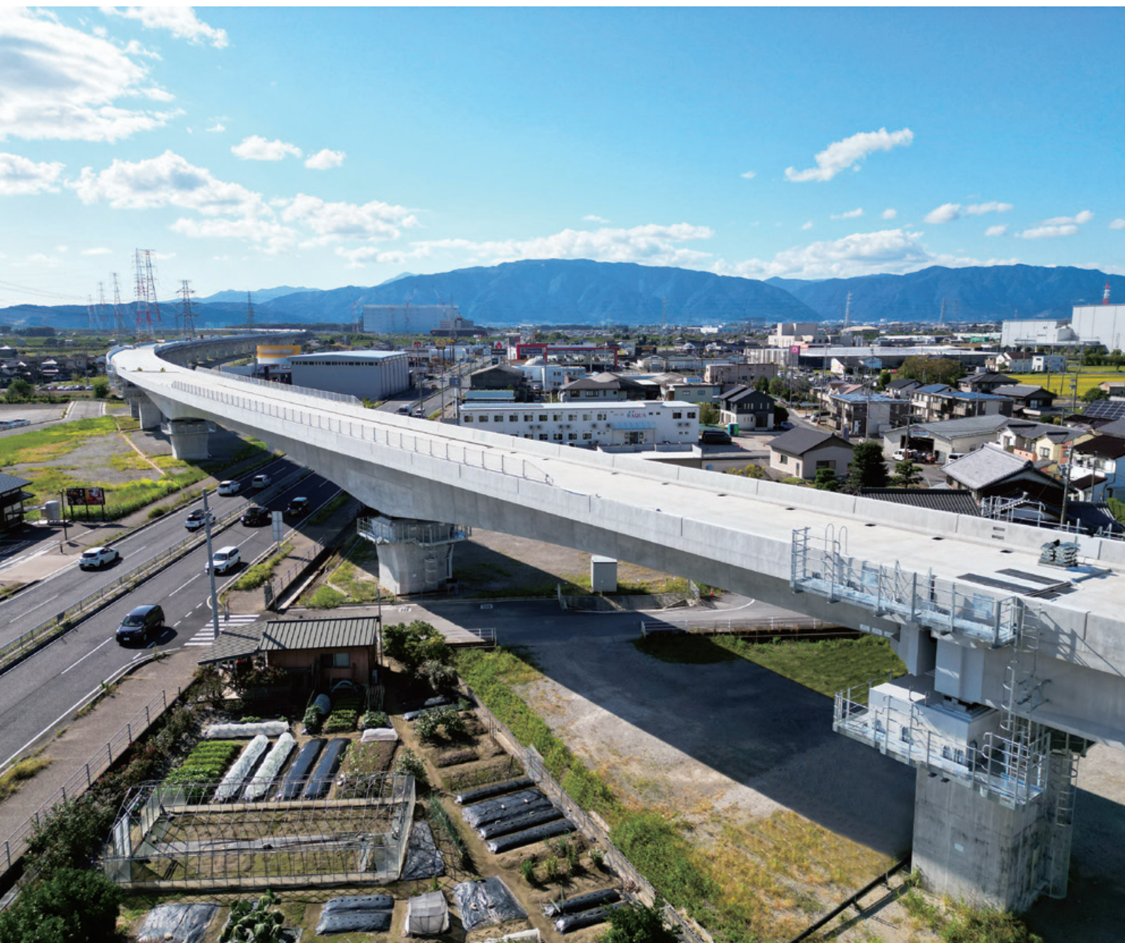
東海環状自動車道 政田第三高架橋他2橋（PC上部工）工事〔岐阜県〕
