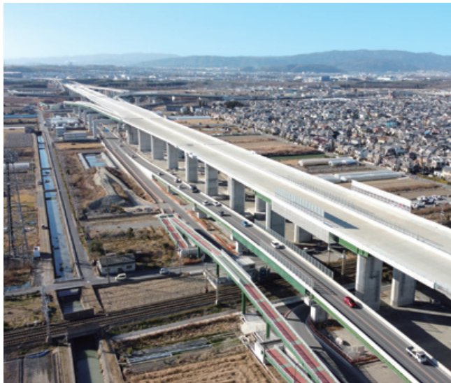
新名神高速道路 城陽第二高架橋西 (PC上部工) 工事 (京都府)
