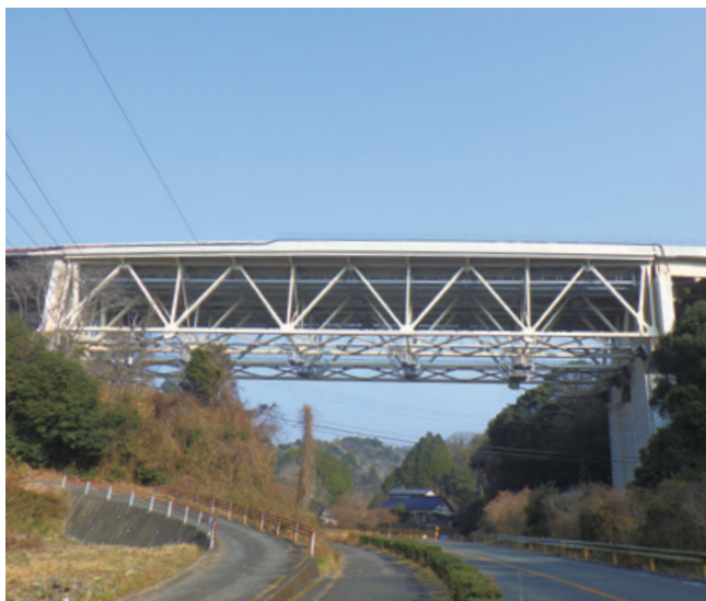
中国自動車道 (特定更新等) 四十八瀬川橋他1橋床版取替工事 (山口県)
