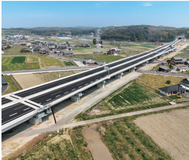
東海環状自動車道 上保高架橋 (PC上部工) 工事 (岐阜県)
