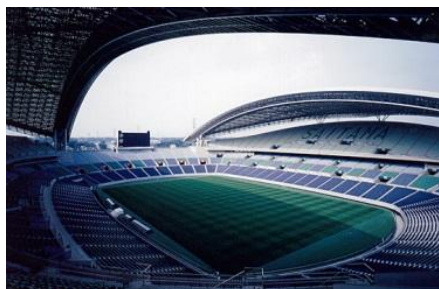
埼玉スタジアム2002 (PC躯体工事)
