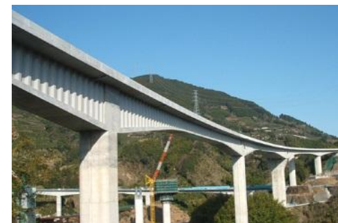
第二東名高速道路伊佐布2号高架橋 (PC上部工)下り線工事
