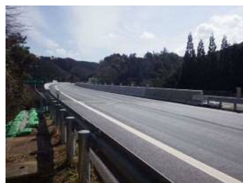
竣工(道谷第二橋)
