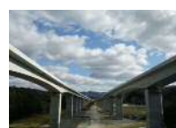
新名神高速道路 猪名川橋(兵庫県)
