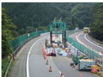
床版取替状況(道谷第二橋)
