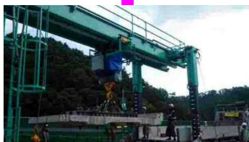
撤去床版の搬出
