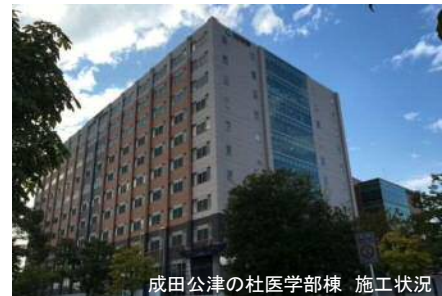
成田公津の杜医学部棟 施工状況
