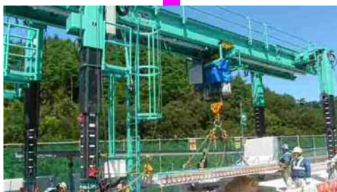
取替床版架設
