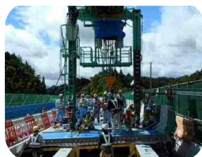
道谷第二橋（上り線）工事
