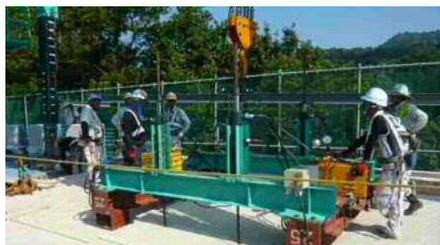
既設床版撤去
