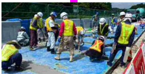
場所目地部コンクリート打設
