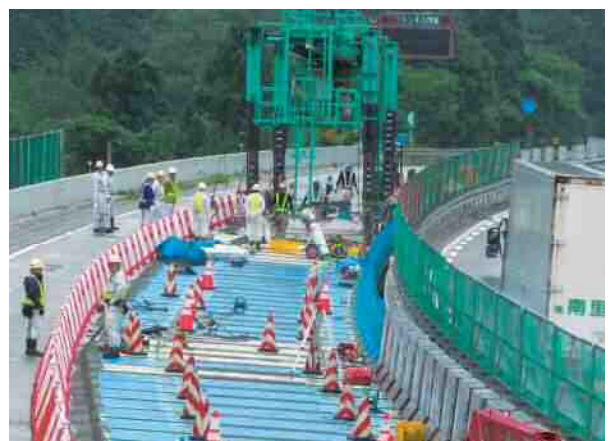
半断面床版取替工法
