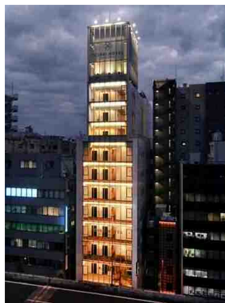
ファサードはオフィスビルのガラスカーテンウォールのままサイドの外壁を改修
