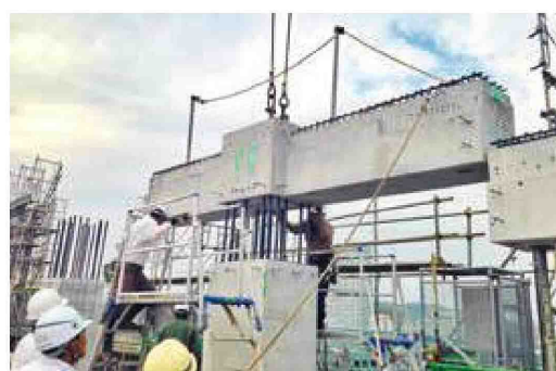
PCaPC梁部材仮設状況
