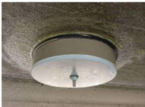
飛来塩分や凍結防止剤により劣化した構造物(PC桁、RC構造物)に適用可能な補修工法です。
