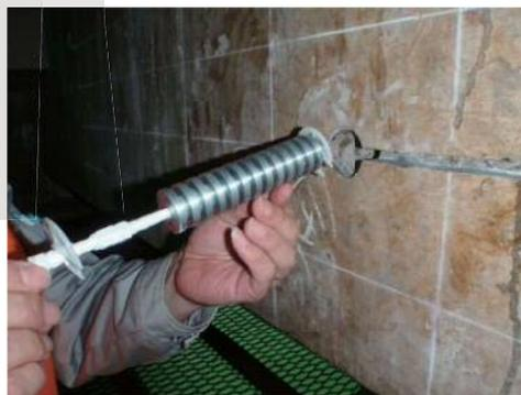
飛来塩分や凍結防止剤により劣化した構造物(箱桁端・RC栈橋・鋼桁のRC床版・地下トンネル等)にZnカートリッジを挿入します。
