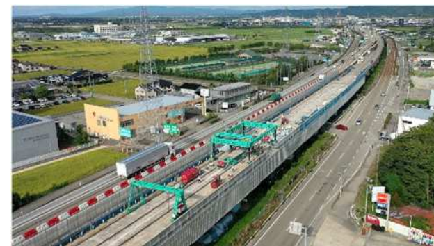
（北陸自動車道）金沢高架橋東床版取替工事 本工事では、高圧線の交差箇所があるため、施工高さを抑えた「低空頭タイプ床版架設機」を採用
