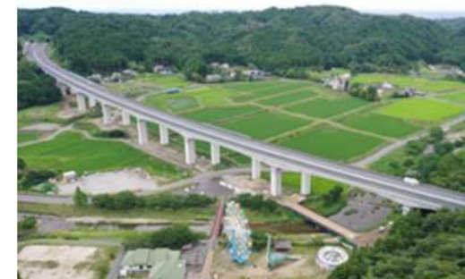
常磐自動車道大久川橋
