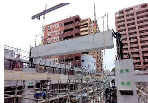
現在施工中の「福岡中央病院新築工事」では当社が得意とするPCaPC工法を採用
