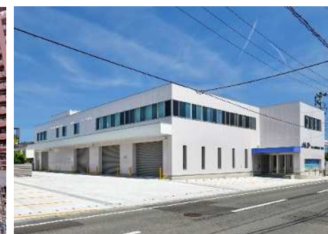
2024年に竣工した当社設計・施工の「青森三菱電機機器販売(株)青森支店建替工事」では「Nearly ZEB」を実施
