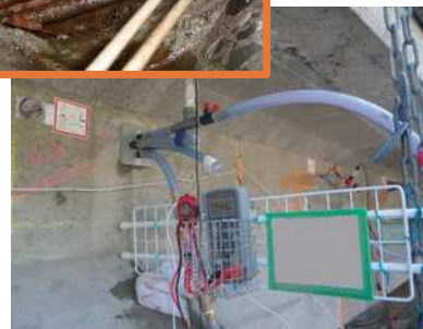
グラウト再注入工法（リパッシュ工法）
