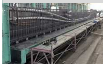
①工場にてPCa部材製作
