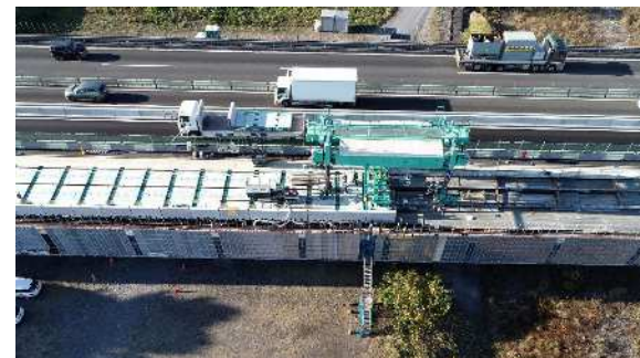
(東名高速道路) 大井川橋床版取替工事 本工事は、重交通路線の床版取替工事であり、渋滞による社会的損失を最小限に抑え、当社が得意とする「半断面施工」を採用
