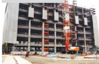
⑥躯体工事完成
