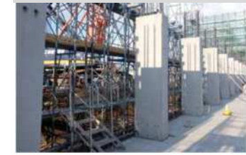
④現場にてPCa部材を組立
