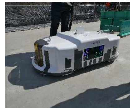
「T-iROBO®Slab Finisher」の適用
