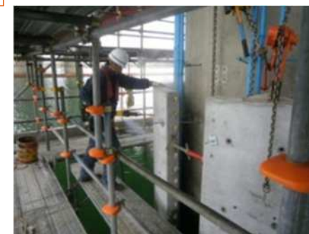
耐震補強（橋脚PCコンファインド工法）
