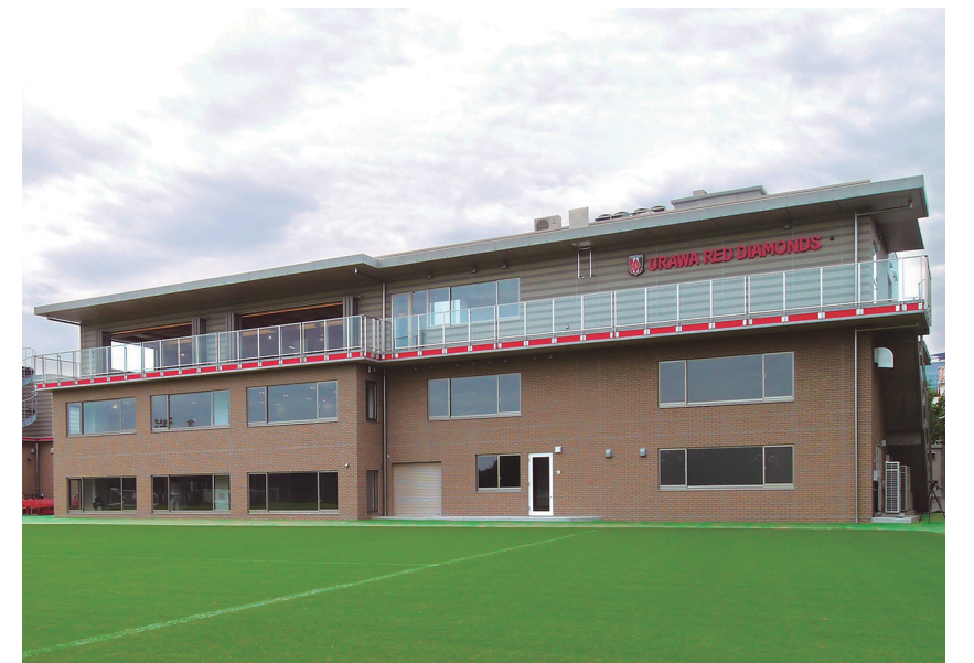
今秋完成した浦和レッズのクラブハウス増築棟。PC工法の強みを活かして柱のないトレーニングルームを実現した
