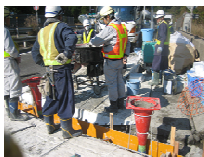
断面修復材充填
