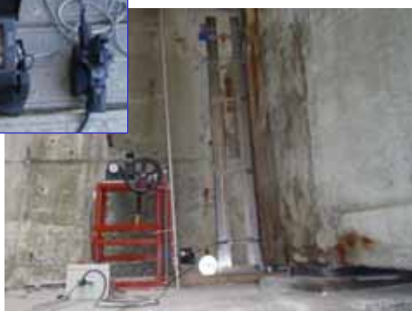
桁端狭隘部の損傷状況調査
