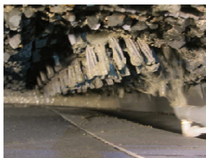
鉄筋防錆材塗布
