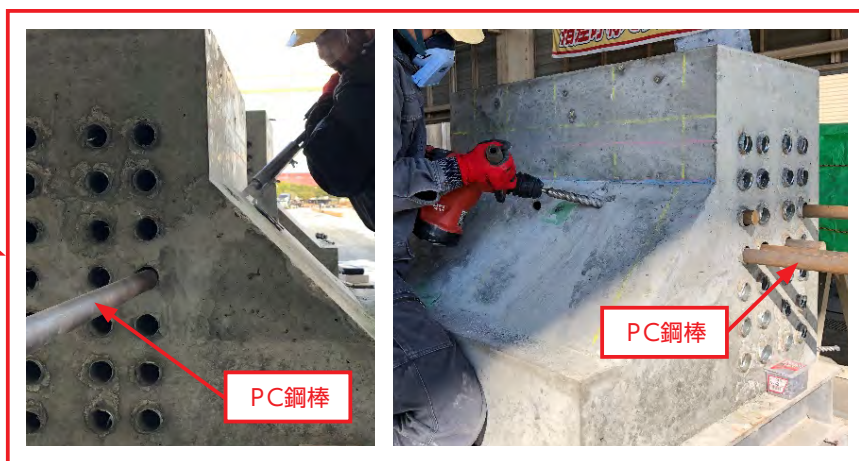
密集配置されたPC鋼棒への注入孔の削孔状況
