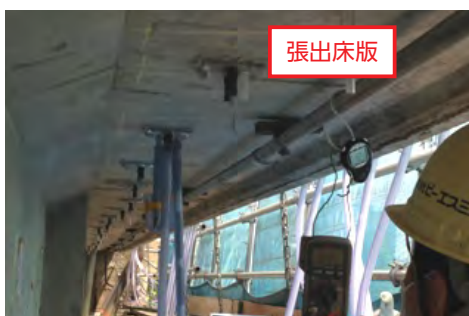
床版横締めPC鋼棒への事例
