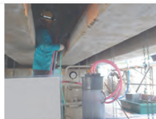
真空ポンプを用いたエアリフト式注入
