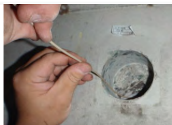
排気チューブ挿入
