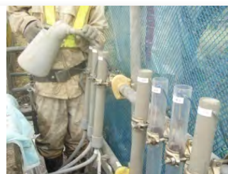
充填完了後のヘッド圧付与
