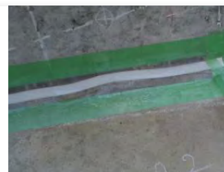
ひび割れ部養生
