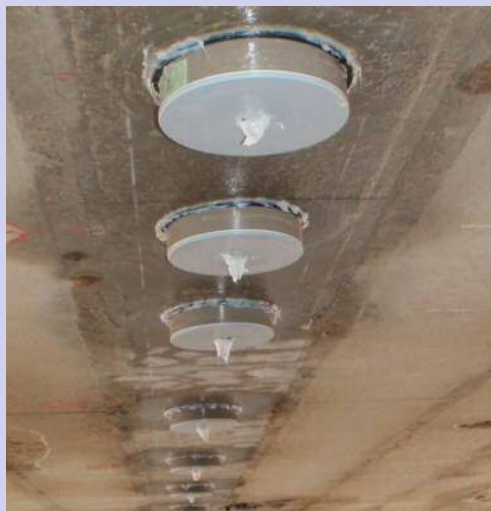
飛来塩分に対する鋼材腐食緩和対策
