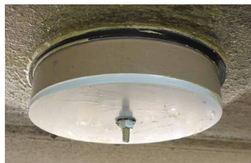
流電陽極材(防食亜鉛) φ110mm、t=5mm
