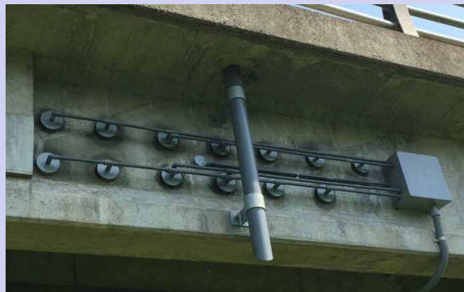
グラウト充填不足部からの塩化物イオンの拡散に対する 鋼材腐食緩和対策
