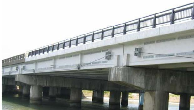
【外ケーブル設置例 (PC箱桁橋)】
