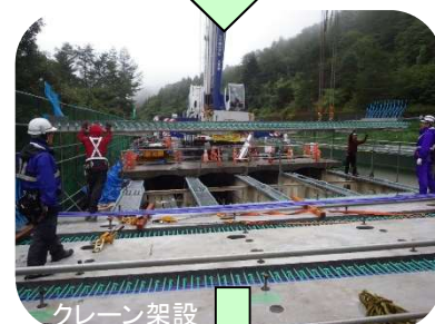
PCa床版の架設
