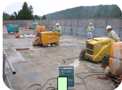
既設RC床版の切断
