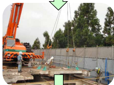
既設RC床版の撤去
