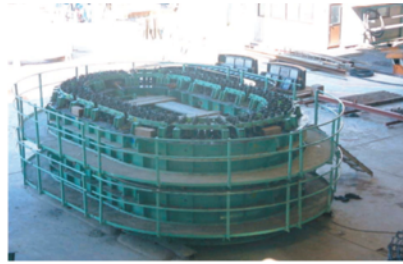
【橋脚ロット製作】
