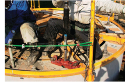
【軸方向鉄筋挿入】
