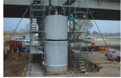
【RCロット据付け】
