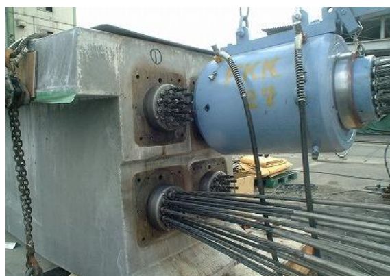
写真-5 実物大 PC 桁の緊張状況
