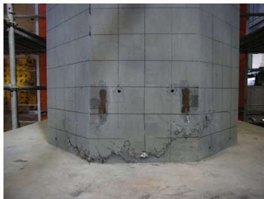
写真-4 破壊状況(基部圧縮縁)
