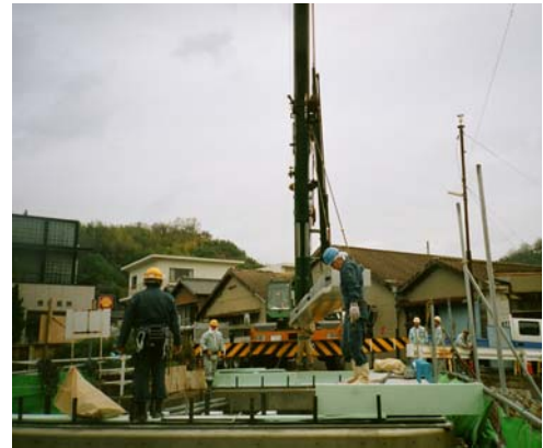
写真-5 主桁架設状況
