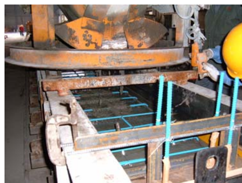
写真-3 打設状況
