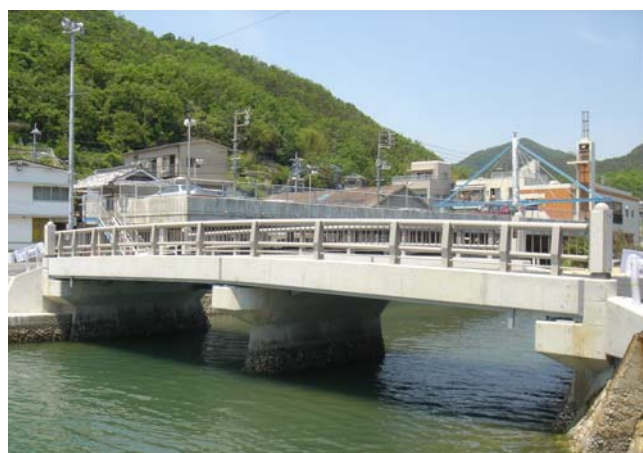
写真-1 橋梁全景
