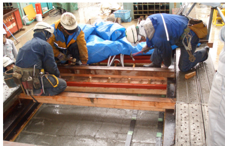
写真－２ 伏せ型枠設置状況
