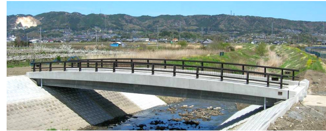
写真－４ 完成状況
