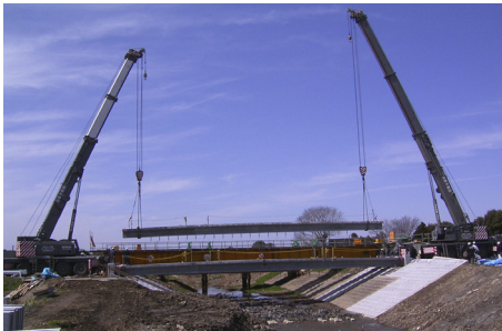
写真－３ 主桁架設状況
