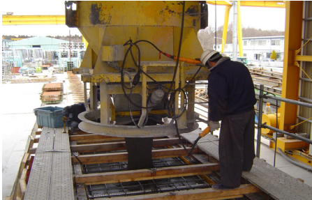
写真－１ 打設状況
