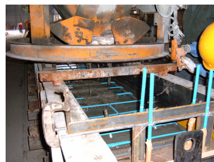
写真－１ 打設状況
