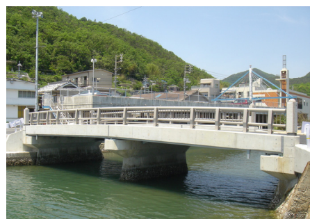
写真－２ 完成状況
