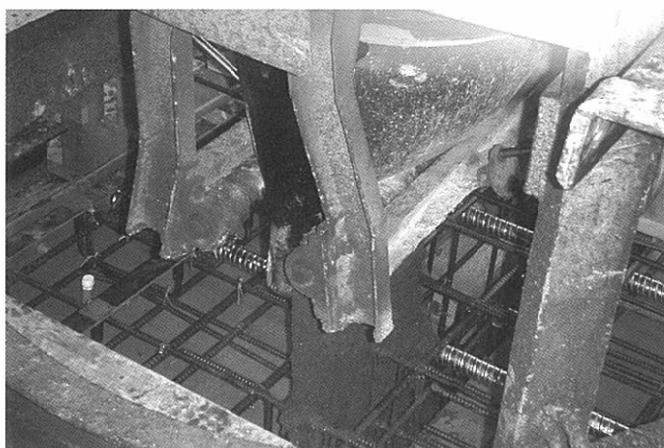
写真-4 主桁打設状況
