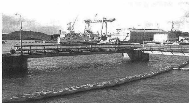
写真-8 カムテックス社の常石栈橋
