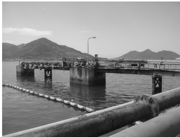
写真-1 既設栈橋状況
