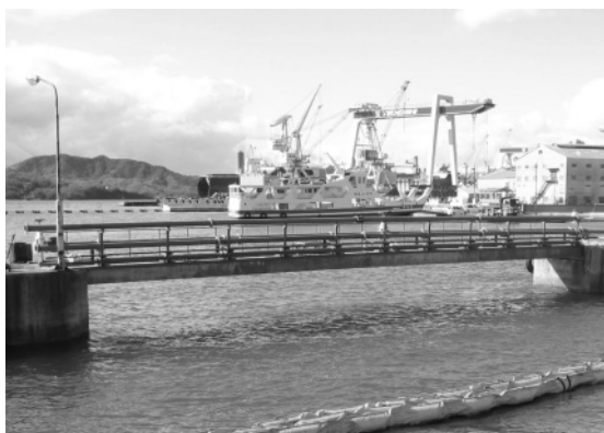
写真-6 完成状況
