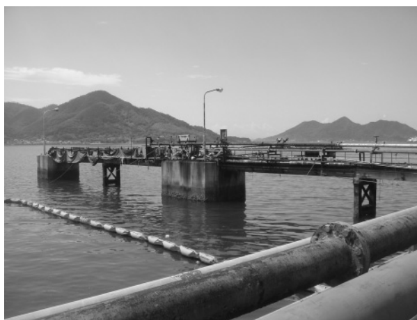
写真-1 既設栈橋状況
