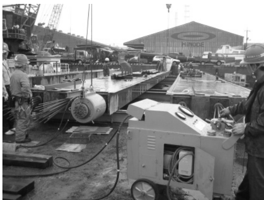
写真-4 緊張作業状況
