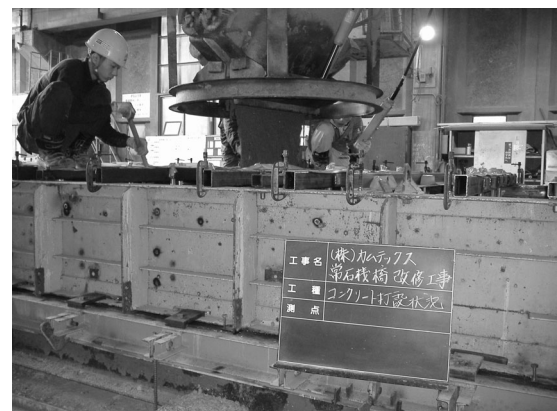
写真-3 打設状況
