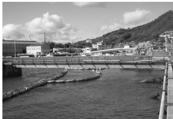
写真-7 完成状況
