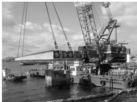
写真-5 主桁架設状況
