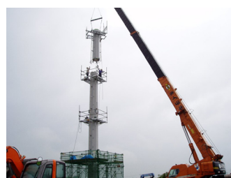
写真-6 建込み状況
