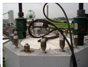
写真-7 PC鋼棒の緊張状況
