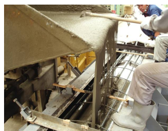
写真-4 打込み状況
